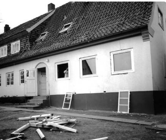
Auch in Sanierungsarbeiten bezog die Genossenschaft regelmäßig Handwerksbetriebe aus der Umgebung mit ein (hier Fensteraustausch in der Friedrich-Ebert-Str.)
