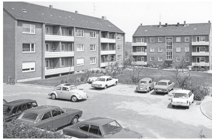
Ab den 1960er Jahren konnten sich immer mehr GWU-Mitglieder ein Auto leisten, so dass verstärkt Parkplätze und Garagen gebaut wurden.
