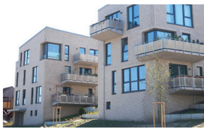
Das Quartier „Noorblick“ am Lorenz-von-Stein-Ring gehört zu den jüngsten Neubauten des GWU in Eckernförde.
